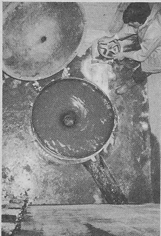
Bild 1. Wirbeldrossel mit geöffnetem Deckel an einem Regenüberlaufbecken
