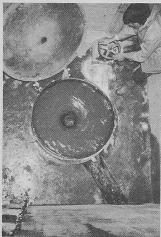
Bild 1. Wirbeldrossel mit geöffnetem Deckel an einem Regenüberlaufbacken
