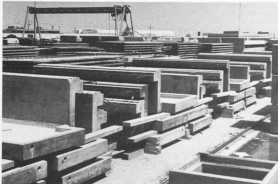
Bild 8. Regierungsgebäude in Kuwait aus Stahlbetonfertigteilen nach niederländischen Entwürfen und Herstellungsverfahren
