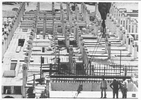
Bild 7. Bau eines Stadtteils mit Wohn- und Verwaltungsgebäuden aus Stahlbetonfertigteilen in Kuweit
