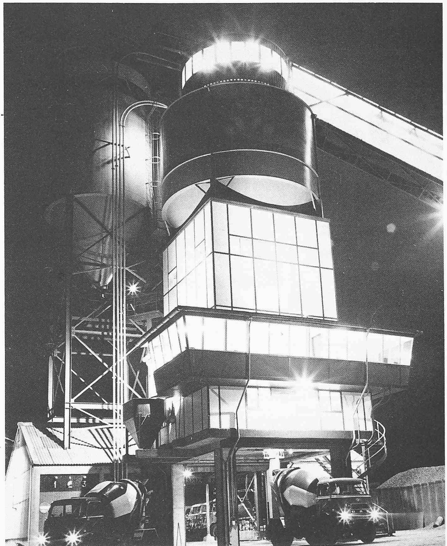
Bild 4. Betonwerk nachts bei Auslieferung von Transportbeton - individuell für jedes Bauwerk und -teil bereitet und überwacht
