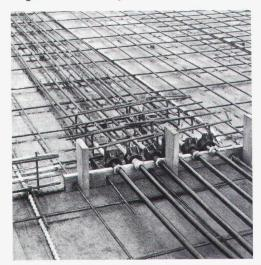
Ende eines Betonierabschnittes mit Zwischenabspannstelle der Spannkabel.
