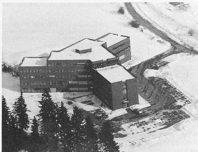
Bild 11. Das Verwaltungsgebäude mit einer Bürofläche von 5000 m 2 wird ohne jede Zusatzheizung monovalent mit dem Massivabsorber-Heizsystem beheizt
