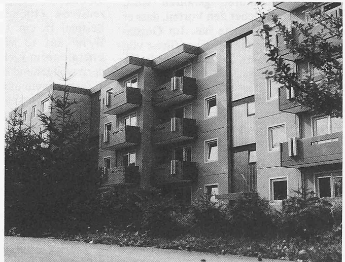
Bild 12. 30-Familien-Haus mit monovalenter Beheizung über ein Massivabsorber-Heizsystem
