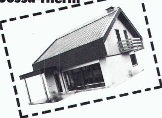
Die Sessa-Therm-Bedachung für die wirtschaftliche Nutzung der Sonnen- und Umweltenergie besteht aus Kupfer mit integrierten Rohren für das zirkulierende Wärmeträgermedium. Das Energiedach nutzt sowohl die Sonneneinstrahlung als auch die in Regen, Nebel und Luft enthaltene Wärme.
