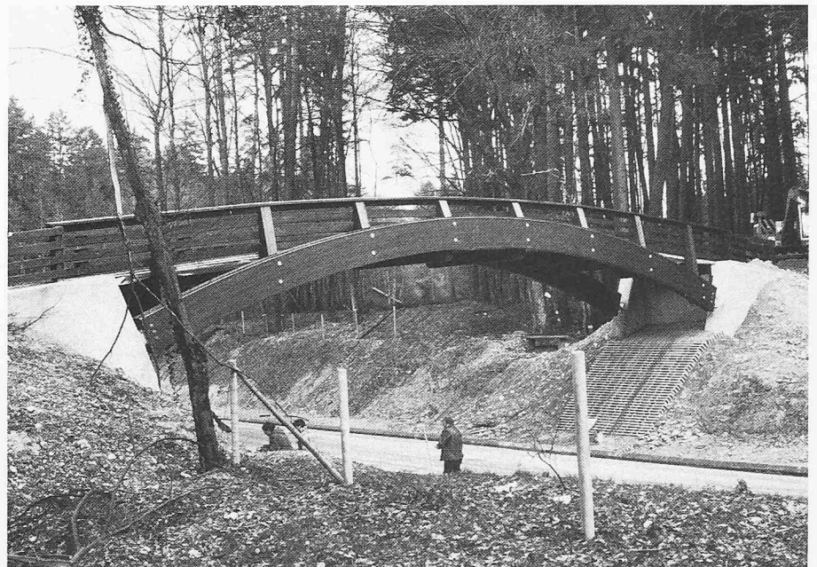
Ansicht der neuen Holzbrücke
