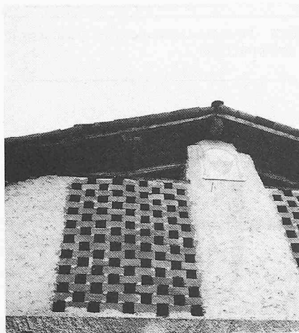
Bild 15. Hauswandöffnung in ornamentaler Backstein-Komposition, Tessin
