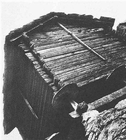
Bild 75. Der gemauerte Sockel mit dem eingeschossigen Holzwerk im Blockbau in Grächenbiel (VS)
