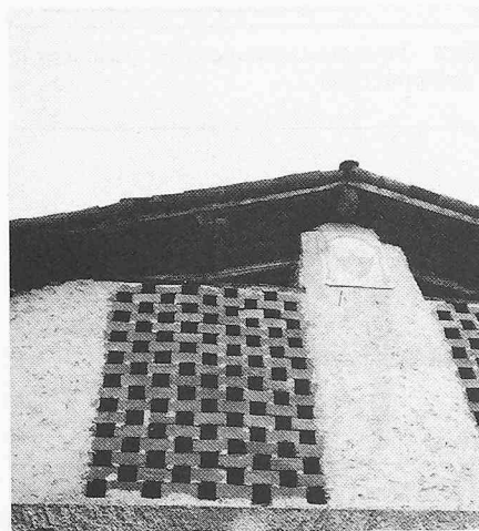
Bild 15. Hauswandöffnung in ornamentaler Backstein-Komposition, Tessin
