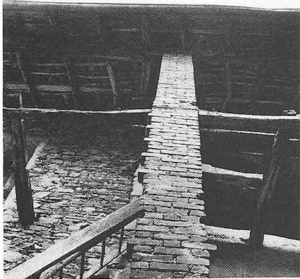
Bild 5. Stein auf Stein im Tessiner Dorf Indemini: Die Dachlast wird von wuchtigen, gemauerten Pfeilern getragen.
