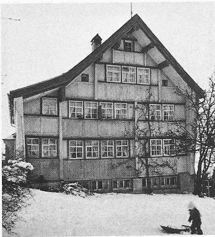
Bild 25. Wohnhaus mit vorgehängter Fassade aus dem Appenzellerland. Die sog. «curtain-wall» besteht hier schon seit 450 Jahren
