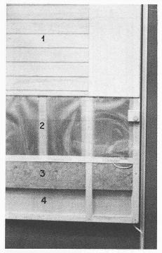
Elektrische Heizfolie. 1 Innenraum-Holztäfer, 2 Heizfolie, 3 Wärmedämmung, 4 Mauerwerk
