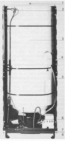
Wärmepumpenboiler. 1 Anschluss zu den Warmwasserentnahmestellen, 2 Expansionsventil, 3 Warmwasserspeicher, 4 Elektrische Zusatzheizung, 5 Verdampfer, 6 Verdichter, 7 Kaltwasserzulauf (beidseitig), 8 Kondenswasserablauf (beidseitig)
