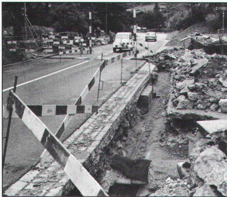
09.57 Das Zugseil ist in den Graben eingelegt...
