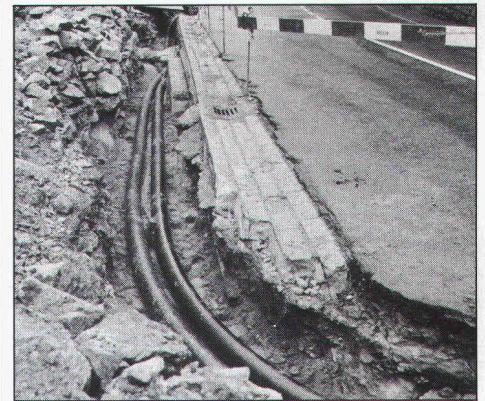
11.55 Komplett verlegt – 360 m nahtlose Fernwärmeleitung – Ziel erreicht!
