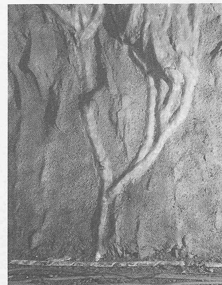
Bild 7. Von Hand angemauerte Drains
