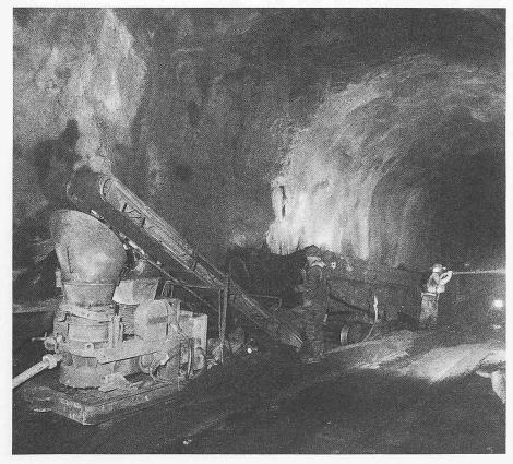
schnellerhärtenden Bindemittel. Im Furka-Tunnel ist das Produkt «Sika-Shot» der Firma Sika AG verwendet worden. Seine Druckfestigkeit beträgt nach einer Stunde 12 N/mm² und nach 28 Tagen etwa 45 N/mm².
