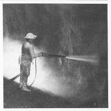
Bild 1. Düsenführer beim Auftrag von Spritzbeton
