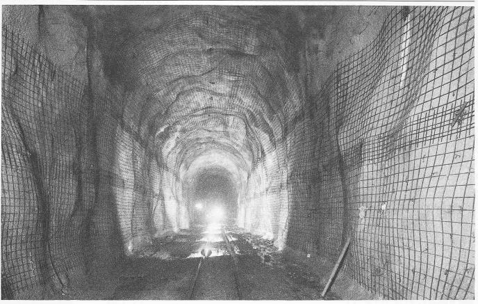
Bild 8. Stahldrahtnetze als Armierung der Spritzbetonauskleidung
