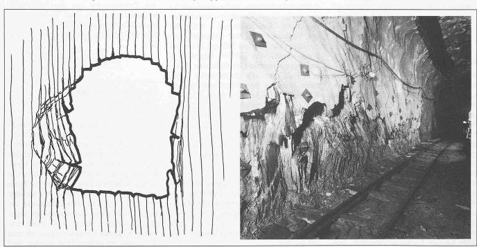
tals, des Goms und des Bedrettotals weit verbreitet. Tunnelbautechnisch führt die Auflockerung des Gebirges, die bis zu einer Auflösung in Einzelblöcke gehen kann, zu einer erheblichen Reduktion der Standfestigkeit.
