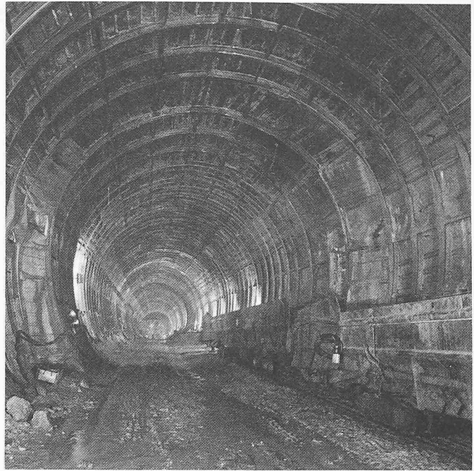
Bild 11. Kreisprofil nach dem Strossenabbau
