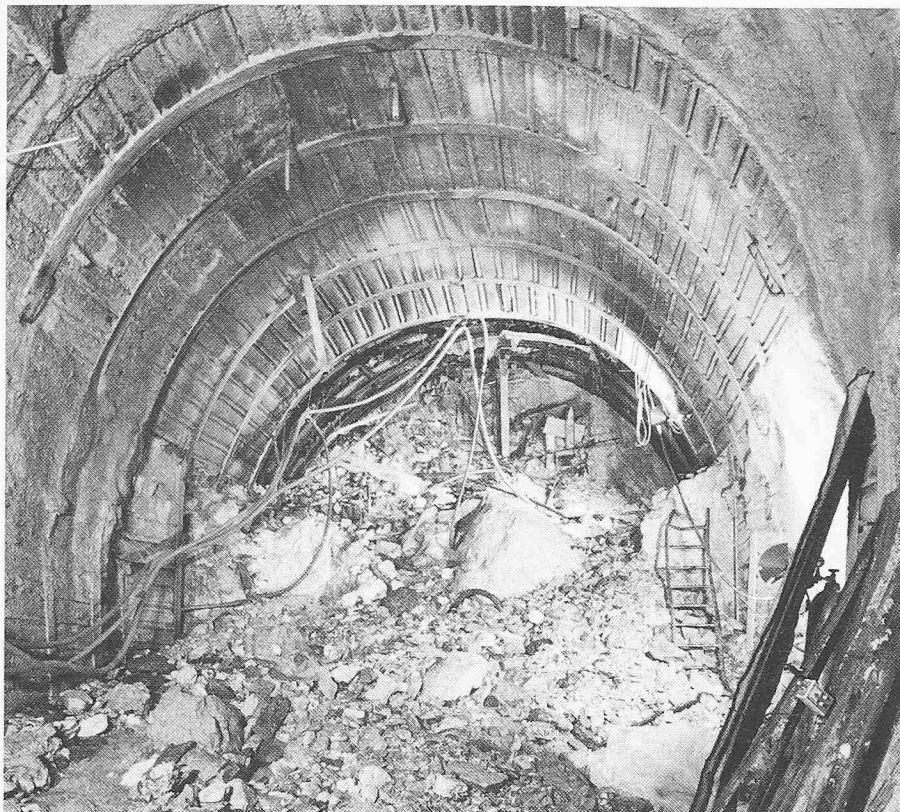
Bild 7 (oben). HuFeisenprofil. Deformationen im Stahleinbau bei Tm 8500
