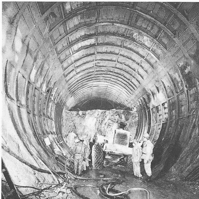
Bild 10. Strossenabbau im Kreisprofil
