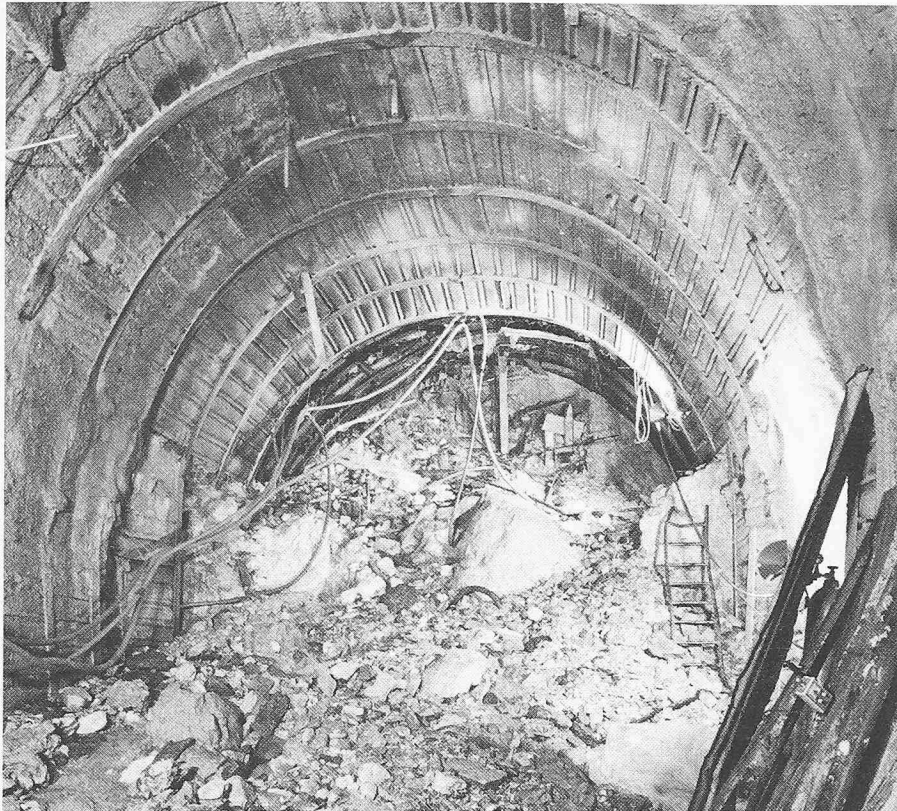
Bild 7 (oben). Hufeisenprofil. Deformationen im Stahlleinbau bei Tm 8500
