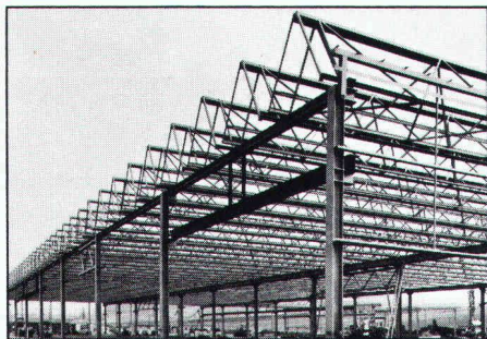
Metallstruktur eines Fabrikgebäudes mit Mini-Sheddach
