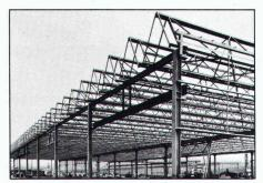
Metallstruktur eines Fabrikgebäudes mit Mini-Sheddach
