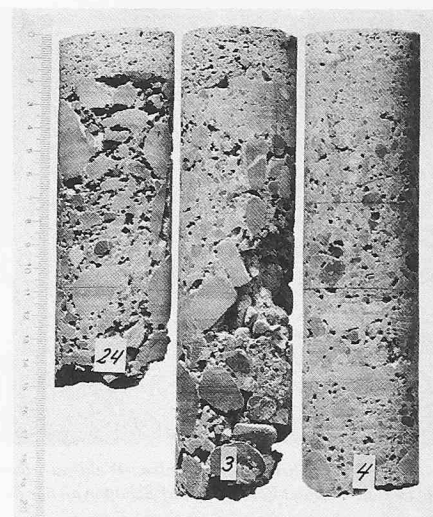
Bild 3. B-065 Bohrkern aus Stampfbeton, Baujahr 1925. Foto EMPA 57751
