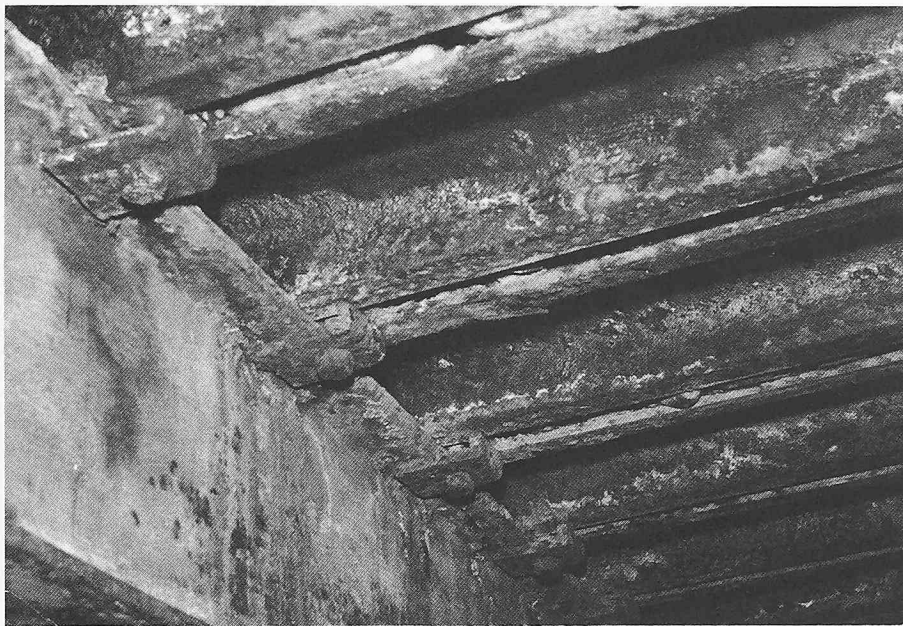
Bild 9. B-001, Verrostete Zoreisenfahrbahn. Untersicht, mit Längsträger (links)
