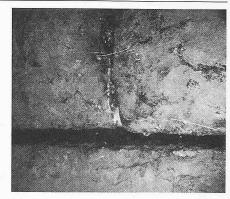
B-001 Rheinbrücke Kaiserstuhl. Unterwasseraufnahme (1977) der ausgewaschenen Fugen im Mauerwerk des Pfeilers, der 1979 saniert wurde
