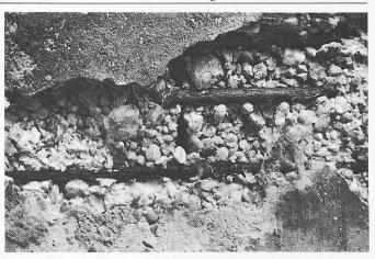
Bild 6. Zu geringe Überdeckung und mangelhafte Betonqualität führen zu Abplatzungen infolge Rosten der Eisen
