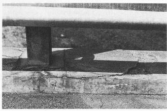
B-731, Brücke über T5, Hunzenschwil. Risse und Betonabplatzungen am Brückenkonsolkopf. Zustand 1980
