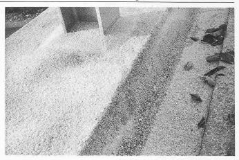
Bild 24. B-731. Fertig sanierter Konsolkopf mit Beschichtung
