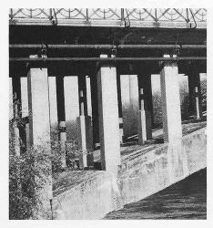
Durch eine Ummantelung der Ständer, wie sie an einer anderen Brücke (Bild 33) ausgeführt wurde, wird das statische System für Verkehrslast, Temperatur usw. geändert und das Zusammenwirken Fahrbahnplatte-Bogen verstärkt. Will man Überbeanspruchungen und damit Schäden vermeiden, bedarf dies stets einer genauen statischen Überprü-
