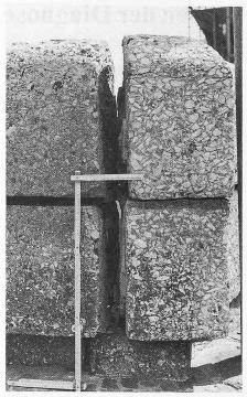
Aus Betonsteinen gemauerte Bogenbrücke B-004, Laufenburg. Durch Zusammenwirken mit dem Bogen verschobene Brüstungen
