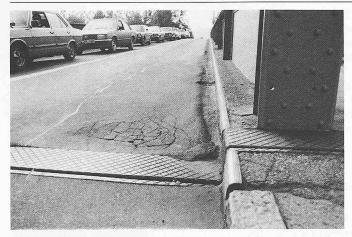
Bild 4. B-003 Rheinbrücke Koblenz-Waldshut. Rosettenförmige Risse im Belag deuteten vor der Sanierung auf Schäden an der Betonoberfläche
