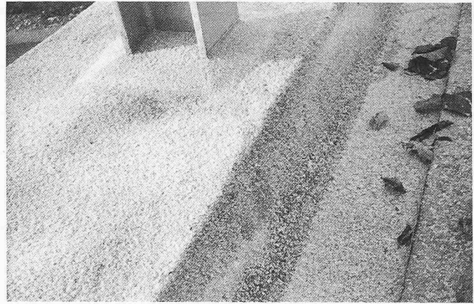
Bild 24. B-731. Fertig sanierter Konsolkopf mit Beschichtung
