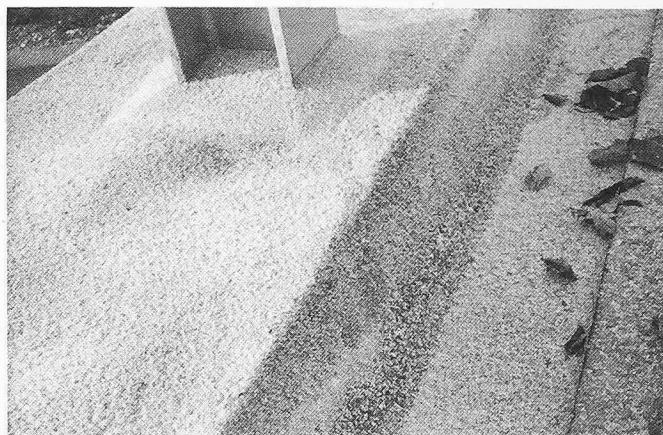
Bild 24. B-731. Fertig sanierter Konsolkopf mit Beschichtung
