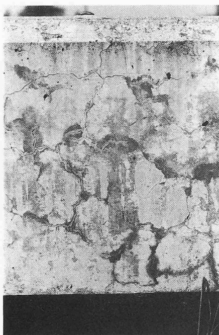
Bild 23. B-731. Netzartige Risse an der Aussenseite des Konsolkopfes. Zustand 1980
