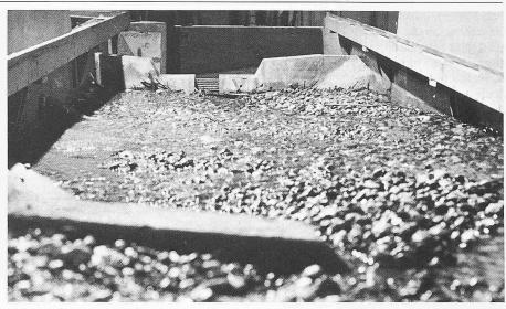
Bild 5. Endstadium nach Versuch 80 (Beschickung von insgesamt 200 000 m³ Geschiebe). Blick von 150 m oberhalb der Sperre bachabwärts
