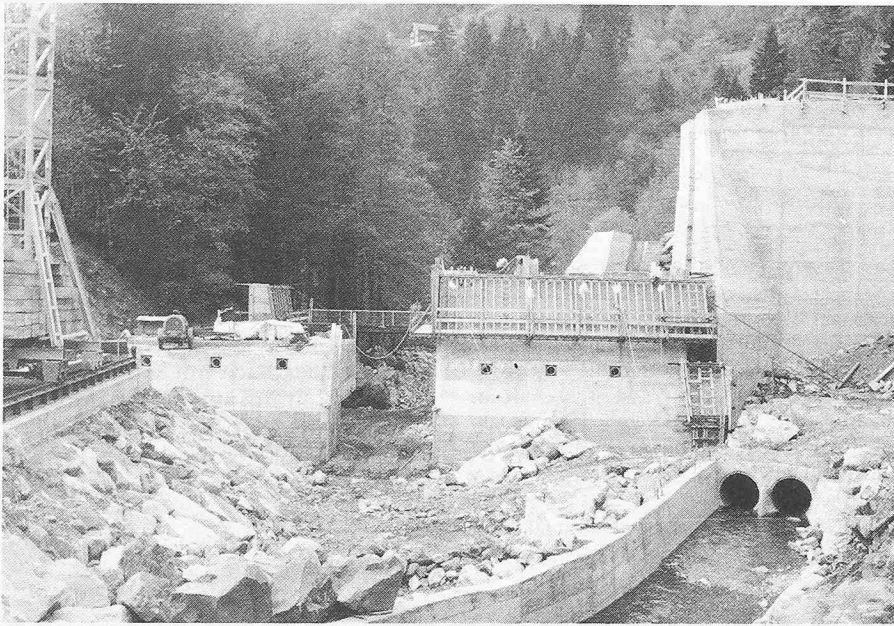
Bild 2. Das Sperrenbauwerk im Bau (12. Mai 1981). Blick aus dem Stauraum bachabwärts. Rechts im Vordergrund erkennt man die beiden Einläufe der Wassenumleitung während des ersten Teiles der Bauzeit (Doppelröhre unter dem rechten Sperrenflügel hindurch)
