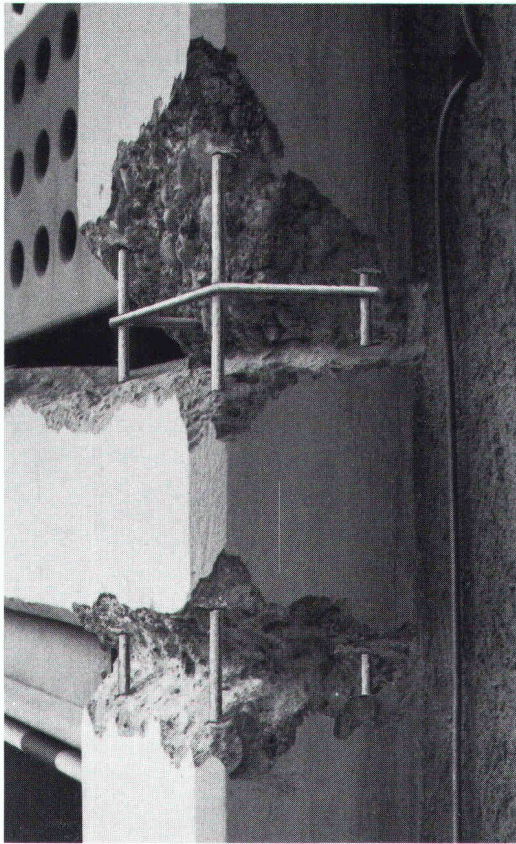
Karbonatisierungsgrad untersuchen, zerstörte Betonteile ausspitzen, Risse injizieren und Armierung schützen.
