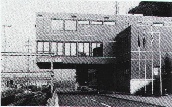
Neues Stellwerk Bahnhof SBB, Olten, Fahrbahnisolierung
