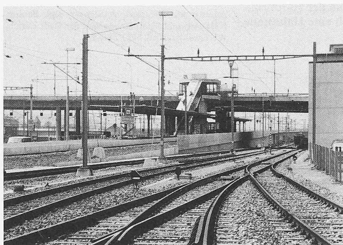
Bild 3. Die Haltestelle «Hardbrücke» im Bauzustand April 1982. Die Treppenaufgänge zu den Bushaltestellen sind gänzlich überdeckt, um die Passagiere vor den Witterungseinflüssen zu schützen und um den Winterdienst zu vereinfachen
