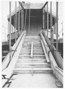
Der Treppenaufgang im Bauzustand April 1982. Die seitliche Einfassung ist bereits montiert
