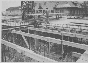
Bild 1. Fertigteildecken mit System Dokaflex 20
