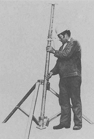
Bild 2. Anklemmbares Falthein für schon vorhandene Deckenstützen
