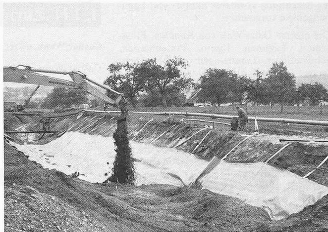
Bild 4. Aufschütten von kiesigem Material auf die verlegten und verschweissten KDB
