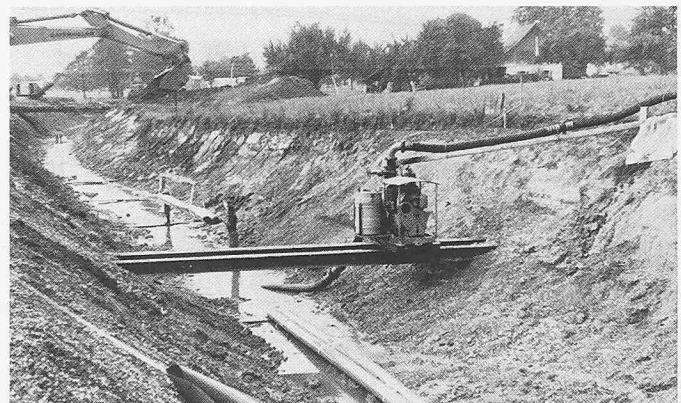
Bild 2. Mit dem Bagger wird eine rund 10 m lange Kunststoff-Dichtungsbahn abgesenkt und in der Kanalachse verlegt. Die beiden Enden der Bahn liegen nach dem Absenken auf vorher bereitgelegten Brettern, wodurch das nachfolgende Zusammenschweissen zweier Bahnen erleichtert wird
