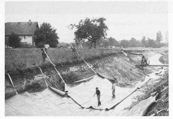
Aufziehen der in Kanalachse verlegten KDB mit Hilfe der eingerollten Bänder
