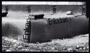
Beispiel einer auf- und abgekanteten Verlegung von Enkadrain.
