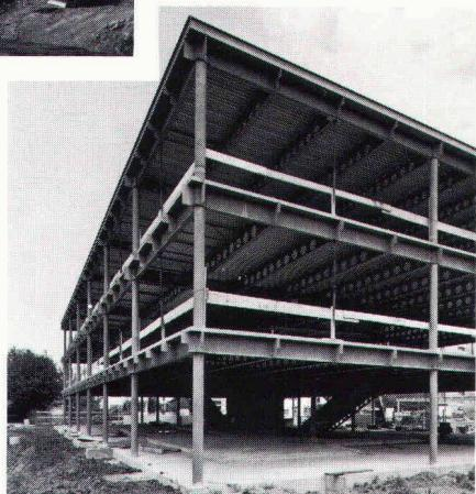
200 Vollstahlstützen für die BIZ
