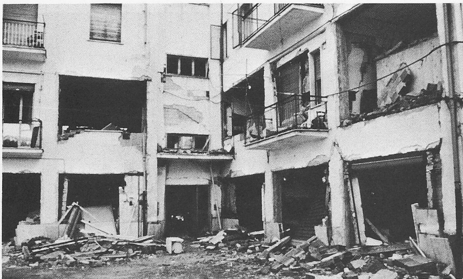
Bild 19. Vollständig zerstörte Ausfachungs- und Zwischenwände im Erdgeschoss und im 1. Stock eines L-förmigen Gebäudes in San Angelo dei Lombardi (Intensität IX)
