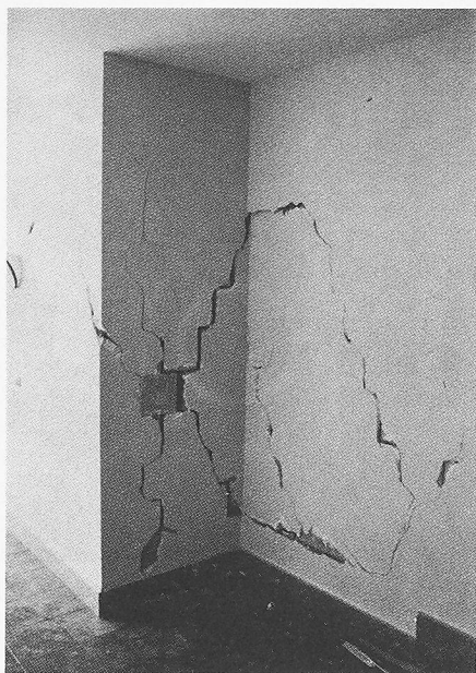
Bild 16. X-förmige Risse im Eingang eines 10stöckigen Stahlbetonskelettbauwerks in Avellino als typischer Schaden bei Intensität VII
