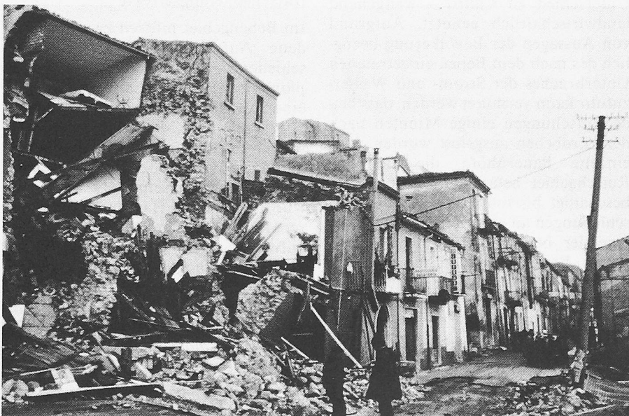
Bild 9. Zerstörte Häuser über einer Anrissstelle der Rutschung in Calitri
