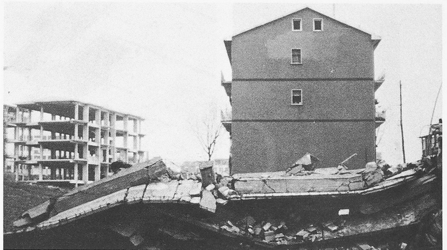
Bild 13. Stahlbetonskelettbau (im Hintergrund) in der Bauphase. Geschossdecken und Dachkonstruktion sind in Hourdis-Bauweise ausgeführt, die Ausfachung erfolgt mit Backsteinwänden. Unterschiede im Schadengrad waren auf kleinste Distanzen anzutreffen: während das 4stöckige Gebäude im Vordergrund total einstürzte, konnten beim hinteren Gebäude von aussen praktisch keine Risse festgestellt werden (Lioni)
