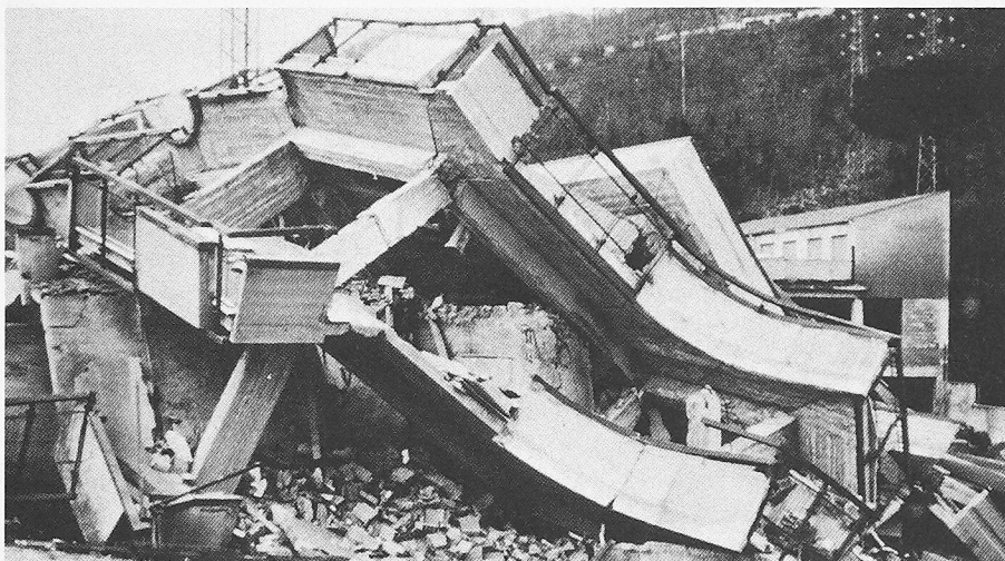
Bild 18. Total eingestürztes 4stöckiges Gebäude eingangs San Angelo dei Lombardi (Intensität IX)
