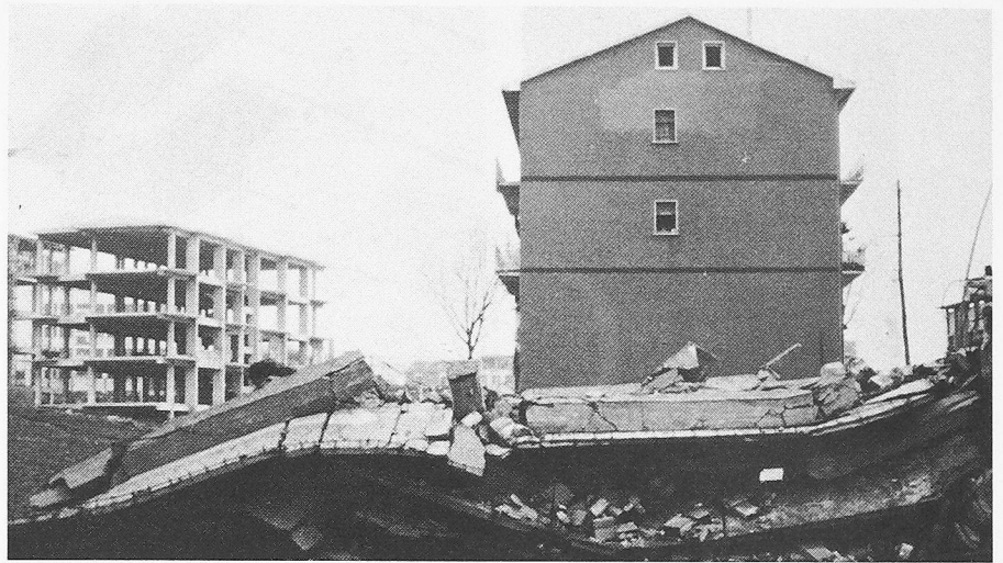
Bild 13. Stahlbetonskelettbau (im Hintergrund) in der Bauphase. Geschossdecken und Dachkonstruktion sind in Hourdis-Bauweise ausgeführt, die Ausfachung erfolgt mit Backsteinwänden. Unterschiede im Schädengrad waren auf kleinste Distanzen anzutreffen: während das 4stöckige Gebäude im Vordergrund total einstürzte, konnten beim hinteren Gebäude von aussen praktisch keine Risse festgestellt werden (Lioni)
