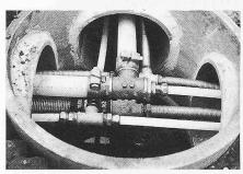
Bild 8. Blick in den Abzweigschacht vor dem Ausschäumen
