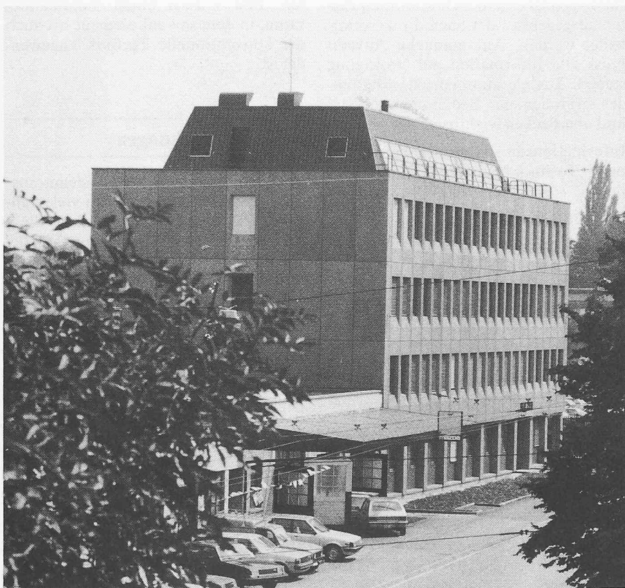
Bild 1. Aussenansicht des Bürotraktes. Sonnenkollektoren in Dach integriert
