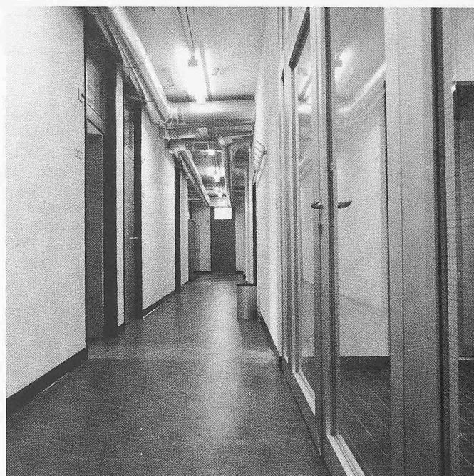
Bild 3. Sichtmontage der Zu- und Abluftrohre und Lichtinstallationen
