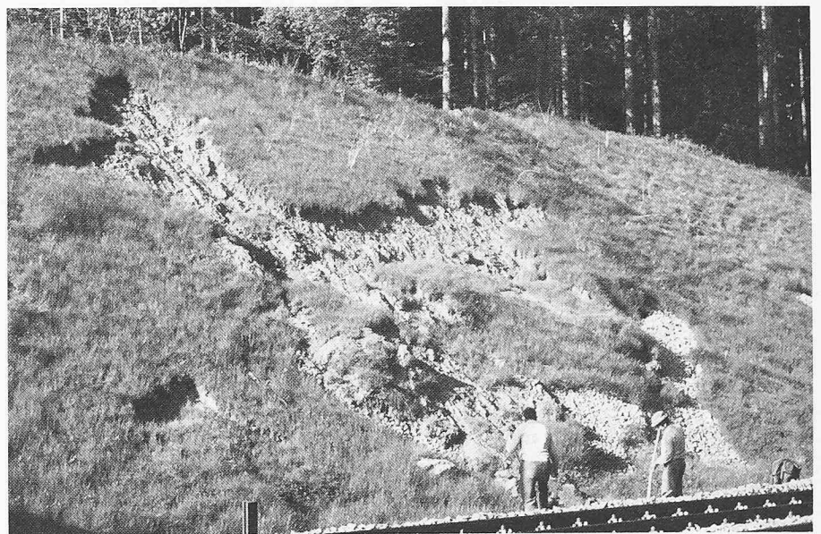
Durch die Einwirkung von Eis und Schmelzwasser wurde die Vegetationsschicht im Frühjahr 1981 wie ein Fell abgeschält. Sie übermurt die Sickerpackungen am Böschungsfuss
