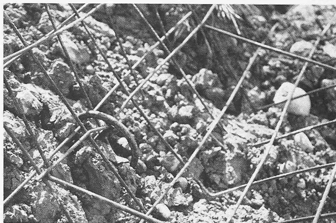
Schiechtelgitter sind dreidimensional verformte Armierungsnetze, die zusätzlich verstrebt worden sind. Sie wurden mit Armierungsseilen auf dem Untergrund fixiert
