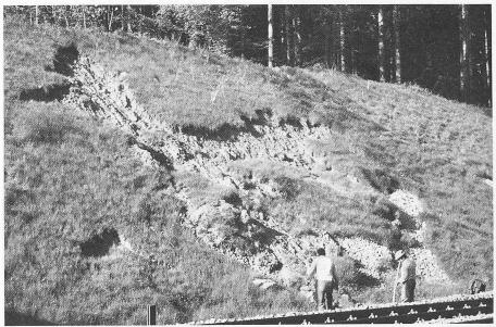
Durch die Einwirkung von Eis und Schmelzwasser wurde die Vegetationsschicht im Frühjahr 1981 wie ein Fell abgeschält. Sie übermurte die Sickerpackungen am Böschungsfuss
