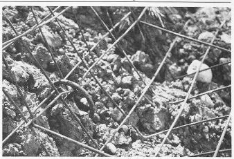
Schiechtelgitter sind dreidimensional verformte Armierungsnetze, die zusätzlich verstrebt worden sind. Sie wurden mit Armierungseisen auf dem Untergrund fi-
