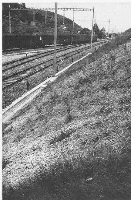
Den wiederhergestellten Rutschflächen fehlt ein Erosionsschutz. Deshalb wurden sie mit langhalmigem Stroh ausgelegt, angesät und leicht mit Bitumen fixiert
