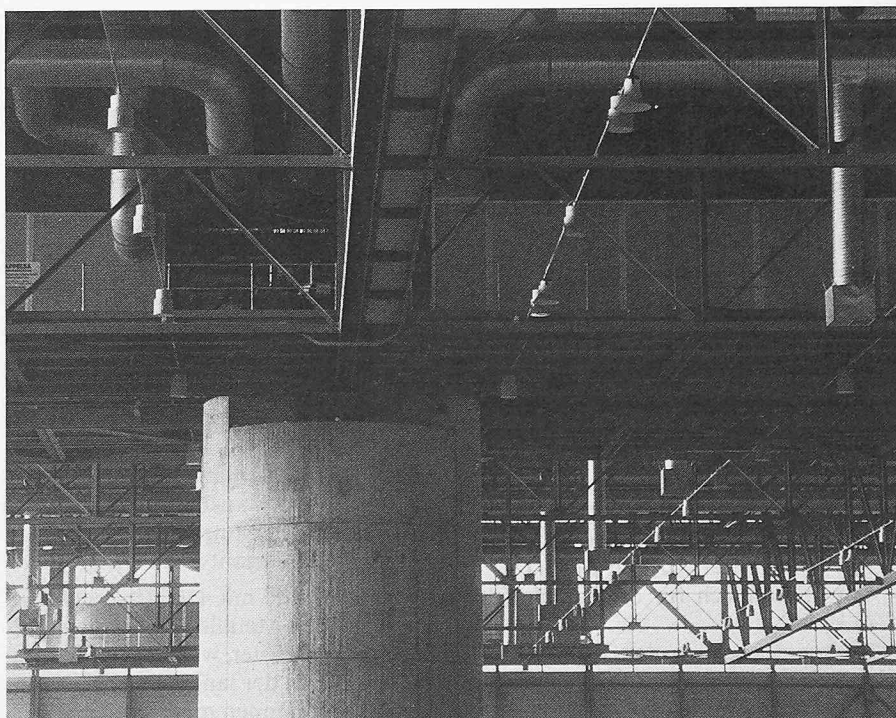
Fertige Stahlkonstruktion im Bereich eines Auflagerturms
