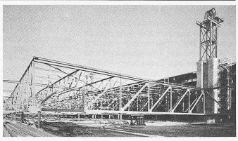
Bilder oben und unten: Montage der Stahlkonstruktion
