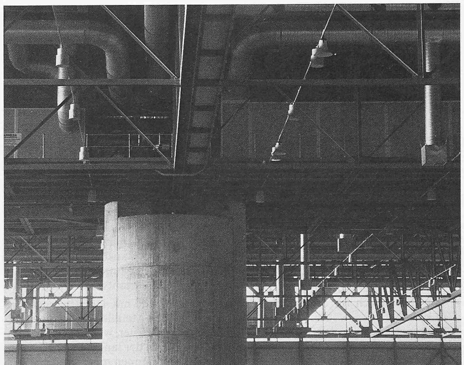
Fertige Stahlkonstruktion im Bereich eines Auflagerturms
