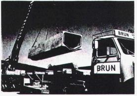
Zugegeben: Ganz so schön wie die der alten Römer sind unsere Kanalelemente nicht. Dafür aber weniger aufwendig. Um sie zu verlegen, muss wenig Erde bewegt werden. Und über der Erde genügt alle acht Meter eine Stütze. Ob so oder so, die Montage ist immer sehr einfach.
