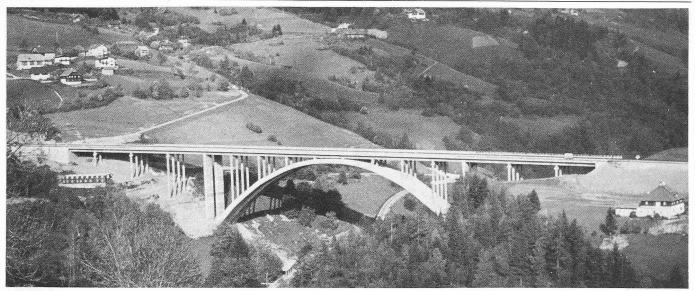
Bild 4. Bogenbrücke mit 167 m Spannweite für den Talübergang L26 Leobengraben für die Tauernautobahn im Liesertal in Kärnten
