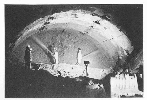
Bild 16. Sichern des Kalottenausbruchs (30 m²) nach der Neuen Österreichischen Tunnelbauweise mit Felsankern, Stahlbögen und bewehrtem Spritzbeton mit Längsschlitzen als Bewegungsfugen
