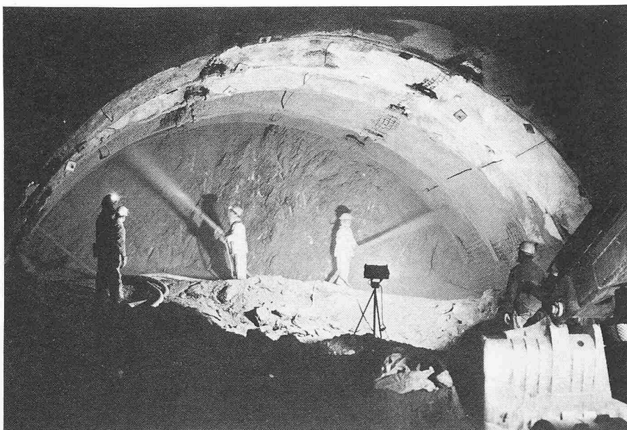
Bild 16. Sichern des Kalottenausbruchs (30 m 2 ) nach der Neuen Österreichischen Tunnelbauweise mit Felsankern, Stahlbögen und bewehrtem Spritzbeton mit Längsschlitz als Bewegungsfugen
