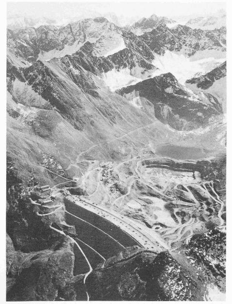
Bild 8. Staudamm für den Speicher Finstertal (60 Mio m³; 2325 m ü. M.) für die Oberstufe der Kraftwerkgruppe Sellrain-Silz. Ende 1979
