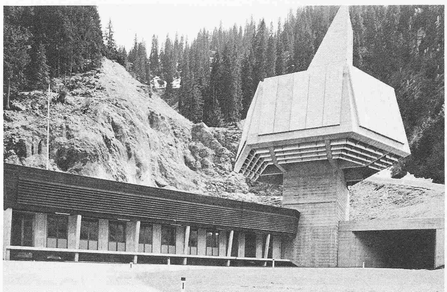
Bild 14. Lüfterstation und Betriebsgebäude in Langen am West-Portal des Arlberg Strassentunnels
