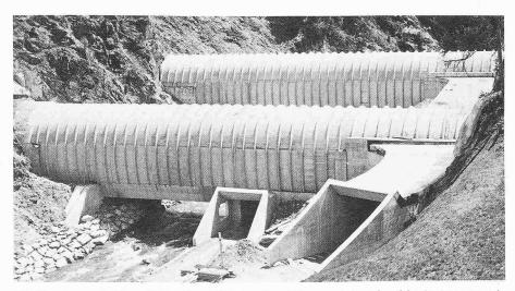
Bild 13. Rosannabrücken mit Einwölbung für beide Tunnelröhren sowie Betriebszufahrt St. Anton am Arl-
