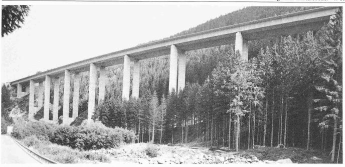
Bild 1. Die 1167 m lange Hangbrücke Puchreit mit Spannweiten von 55 m und Pfeilern bis zu 80 m Schaftlänge - die erste Brücke Österreichs in Segmentbauweise
