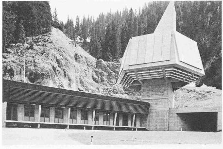
Bild 14. Lüfterstation und Betriebsgebäude in Langen am West-Portal des Arlberg Strassentunnels
