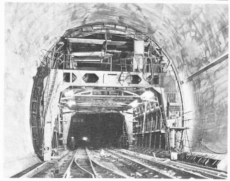
Bild 17. Schalwagen mit Betonierzug. Baulos Ost mit Gleisbetrieb
