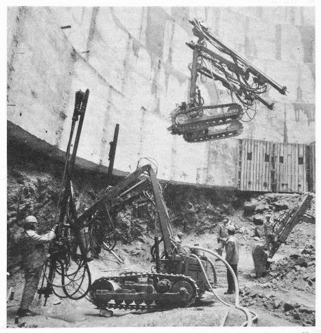
Abteufen des 82 m tiefen Schachtes für das Kraftwerk Küthai; Felswand unter der Betonausklei-Bild 10. dung 3,00 m hoch freistehend
