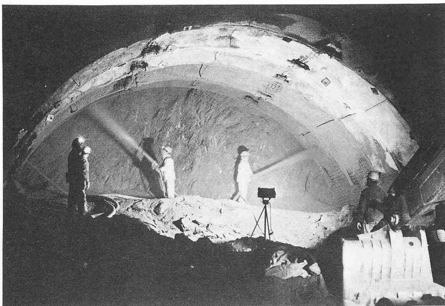
Bild 16. Sichern des Kalottenausbruchs (30 m²) nach der Neuen Österreichischen Tunnelbauweise mit Felsankern, Stahlbögen und bewehrtem Spritzbeton mit Längsschlitz als Bewegungsfugen
