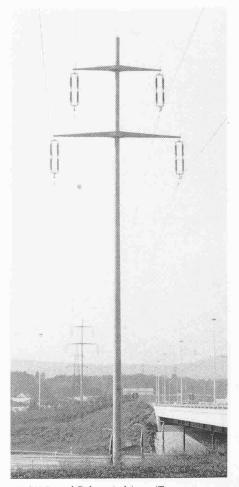
150-kV-Doppel-Bahnspeiseleitung (Tragmast,  $L = 26 - 30 \, m$
