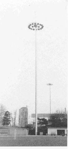
Reispiel eines Schleuderhetonmastes: Beleuchtungsmast (Länge: bis 45 m)
