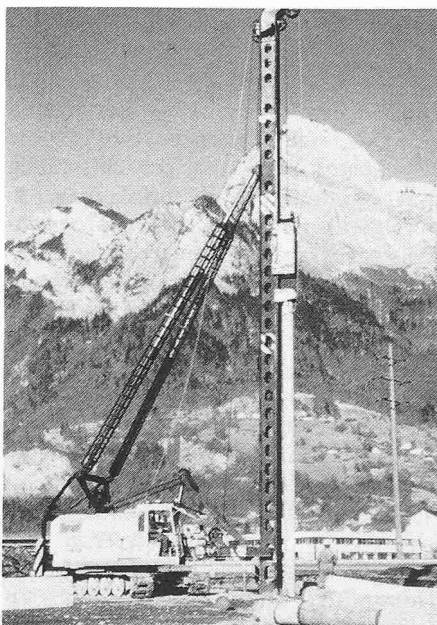
Pfähle für Brückenfundation (Sargans/SG)
