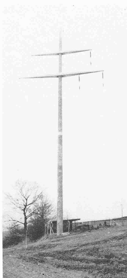
110-kV-Doppelleitung (Tragmast, L = 36-40 m)
