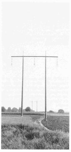
220-kV-Einfachleitung (Tragmast, L = 24-30 m)
