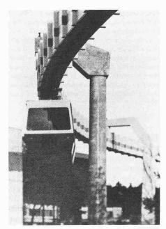
Stütze für Hängebahn (Versuchsstrecke Siemens, Erlangen)
