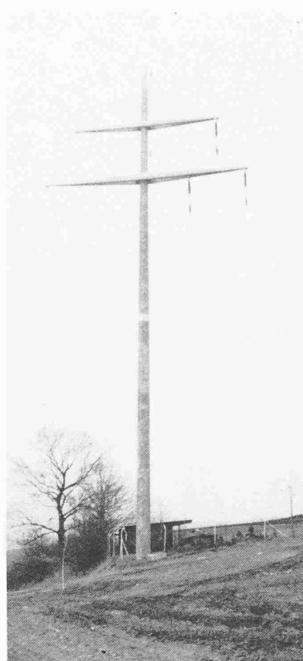
110-kV-Doppelleitung (Tragmast, L = 36\text{--}40\text{ m} )
