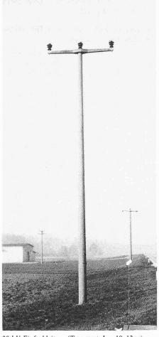
20-kV-Einfachleitung (Tragmast, L = 10-12 m)
