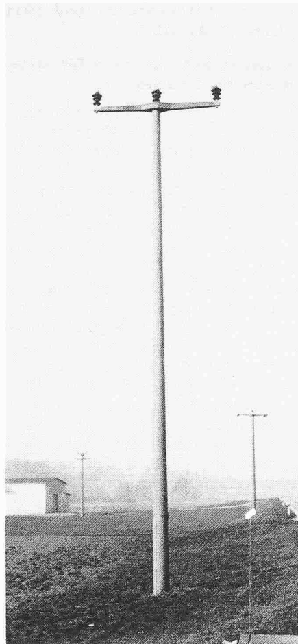
20-kV-Einfachleitung (Tragmast, L = 10\text{--}12\text{ m} )
