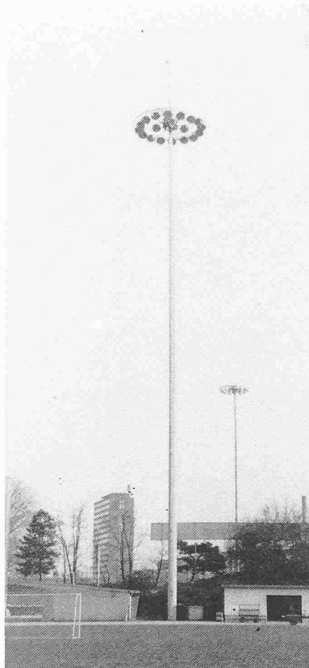
Beispiel eines Schleuderbetonmastes: Beleuchtungsmast (Länge: bis 45 m)
