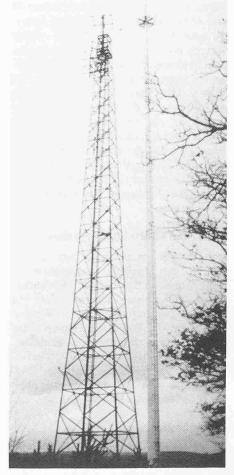
Beispiel eines Schleuderbetonmastes: Antennenmast für Flugsicherung (Länge: 50 m, Vergleich mit Stahlgittermast)
