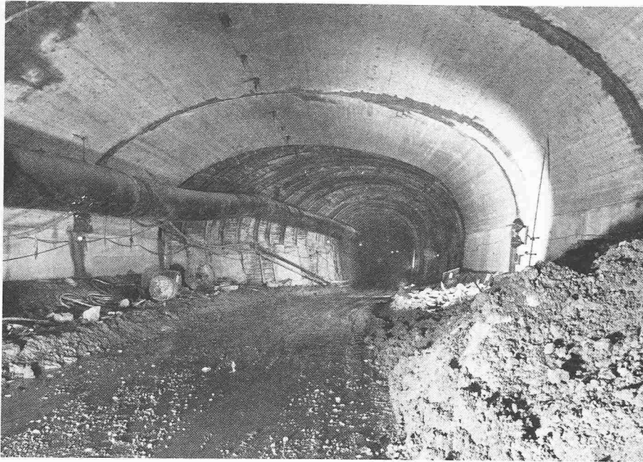
Umfahrungstunnel Oberwald. Übergang von Einspurstrecke zur Doppelspur (60 m 2 ), die im Kalottenvortrieb erstellt wurde
