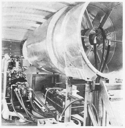
Montagephase: Blick in den Ventilator. Einer der Rohrschalldämpfer ist bereits montiert. Darunter die Diesel- und Hydrauliköltanks
