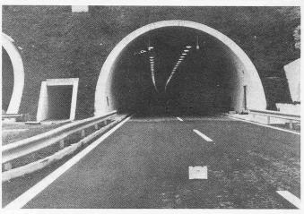
Bild 6. Würfel (20×20×20 cm) sichtbar auf der Fahrbahn im Rugentunnel dank Kontrast, der durch die neuartige Tunnelbeleuchtung hervorgerufen wird
