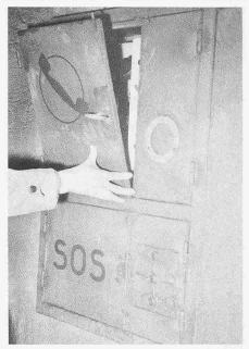
Bild 1. Stark korrodierter SOS-Kasten in einem Nationalstrassentunnel
