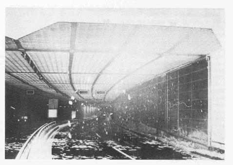
Bild 7. Schneefall durch das Lichtrasterbauwerk im Sonnenbergtunnel
