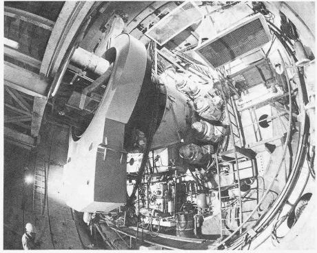
Bild 3. Hintere Ansicht der Vollschnittfräse mit Tübbingerektor im Gubristtunnel
