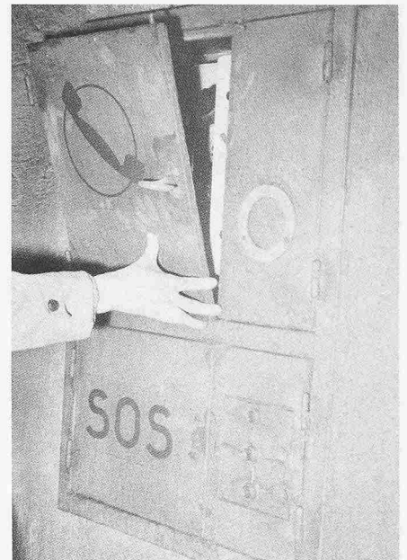
Bild 1. Stark korrodierter SOS-Kasten in einem Nationalstrassentunnel
