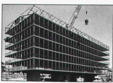
Stahlkonstruktion eines Verwaltungsgebäudes mit an den Dachträgern aufgehängten Zwischenböden
