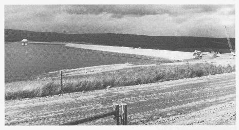
lionen Kubikmeter. Es handelt sich um eine der grössten Speicheranlagen Europas. Das aus dem See fliessende Wasser folgt vorerst 58 Kilometer weit dem Fluss Tyne, dann wird es in einer Druckleitung von sechs Kilometern Länge in eine Höhe von 206 Metern gepumpt. In unterirdischen Kanälen Region von Middelsborough durchfliesst, ein Ballungsgebiet wasserintensiver Industriezweige.
