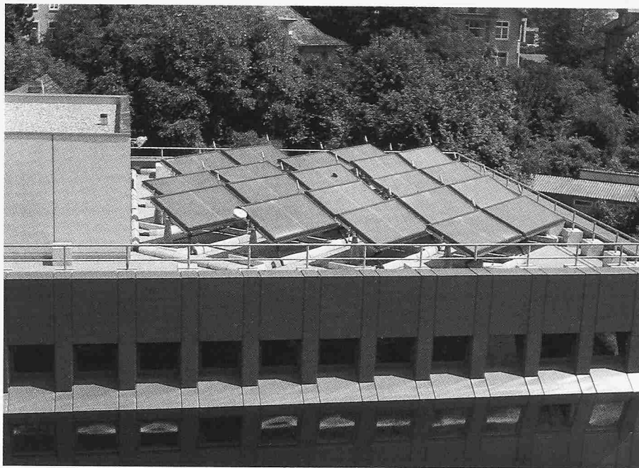
Bild 9. Sonnenkollektoranlage. 20 Elemente mit insgesamt 55 m 2 Absorberfläche. Ausrichtung nach Süden, Neigung verstellbar 30–60°.
