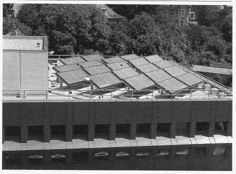
Bild 9. Sonnenkollektoranlage. 20 Elemente mit insgesamt 55 m² Absorberfläche. Ausrichtung nach Süden, Neigung verstellbar 30-60°.
