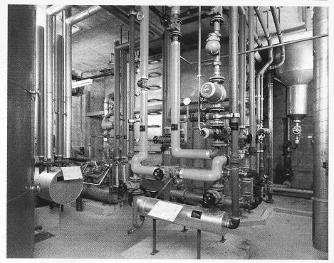
Wärmerückgewinnung aus Abwasser. Abwassertank aus Chromstahl im Hintergrund, Wärmepumpe links hinten und Wärmetauscher Sonnenenergie/Abwasser im Vordergrund
