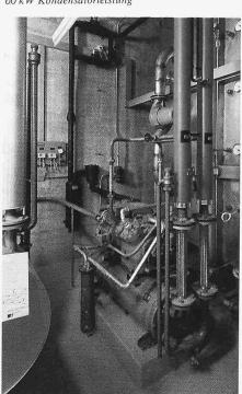
demzufolge nicht mehr genutzt werden, im Gegenteil: durch die Vermischung mit dem wärmeren Abwasser aus den Labors kann auch aus diesem nicht mehr Abwärme entzogen werden. Um das Abwasser trotzdem tiefer abkühlen zu können, wurde nachträglich ein Induktionssystem eingebaut. Mit einer Pumpe wird über ein Düsensystem eine künstliche Strömung entlang den Verdampferplatten erzeugt. Auf diese Weise wurde es möglich, das Wasser auf 0 °C auszukühlen (Tabelle 2).
