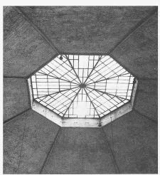
Bild 11. Markthalle in Basel, 1928, Architekt H.E. Ryhner. Achteckige Kuppel des Schalengewölbes in Eisenbeton.
