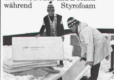
optimal ist bei der Dämmung von Innenwänden, Kältebrücken und verlorenen Schalungen.
