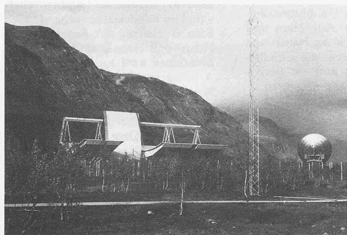
*Inmitten eines weitläufigen Birkenhains im Ramfjordmoen-Tal, etwa 25 km südlich der norwegischen Universitätsstadt Tromsö, stehen die VHF-Antennen (im Vordergrund) und eine der UHF-Antennen des Eiscat-Projekts. Im Bild ist nur das vordere Segment des VHF-Antennenreflektors in die waagerechte Arbeitsstellung geschwenkt. Die Antennen selbst befinden sich unter der am linken Rand aufgesetzten Brücke*
