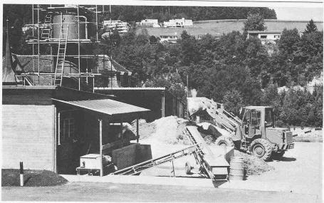
Bild 3. Die provisorische Branntkalkbeimischanlage auf der ARA Bern-Neubrück. In der Baracke ist die Schlammentwässerungsanlage installiert
