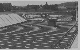
Auf dem Turnhallendach verlegte Niedertemperatur-Kunststoffkollektoren Sessa Exro erwärmen direkt das Schwimmbadwasser der Freibadanlage Bachmatten in Muri (AG)
