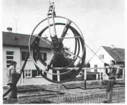
Alle Kabel eines Stützstreifens werden miteinander von der Transportbobine abgerollt und verlegt.
