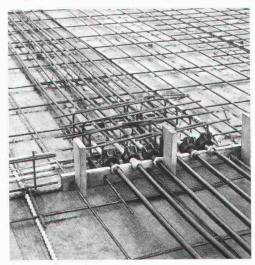
Ende eines Betonierabschnittes mit Zwischenabspannstelle der Spannkabel.
