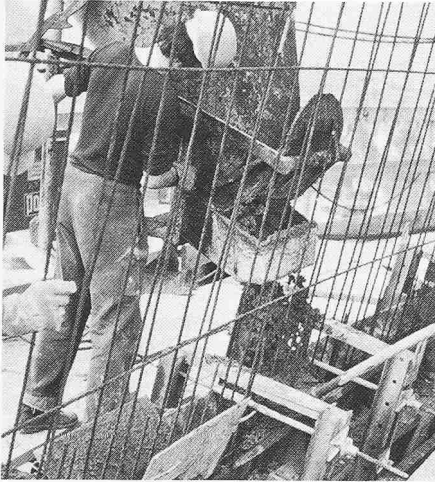
Bild 13. Einbringen von Beton
