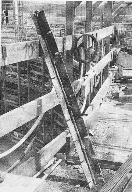
Bild 15. Kammartiges Stahlblech für lotrechte Arbeitsfuge
