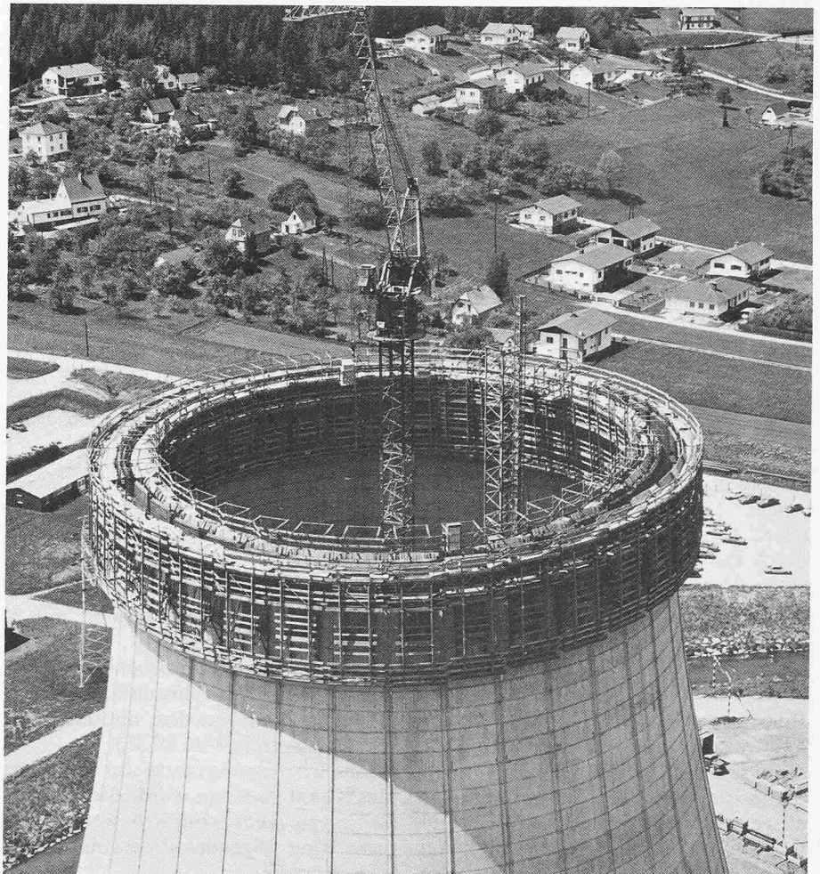
Bild 16 (rechts). Kletterbauzustand im 47. Ringabschnitt
