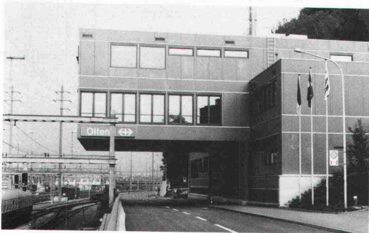
Neues Stellwerk Bahnhof SBB, Olten, Fahrbahnisoliation
