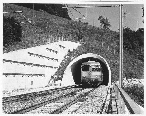
Bild 5. Südportal mit Bohrpfahlwand
