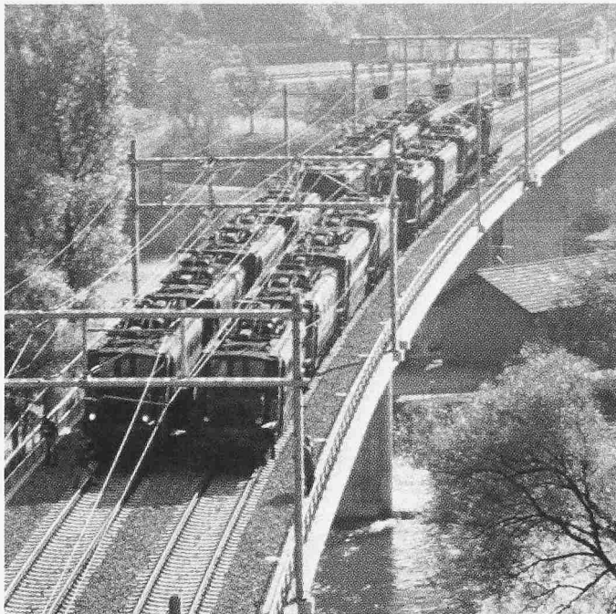
Bild 4. Bremsversuch mit 16 Lokomotiven
