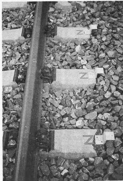
Bild 4. Messpunkte für Einsenkungsmessung
