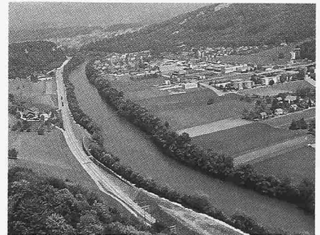
Bild 3. Die Linie im Ruttigertal vom Borntunnel (Nordportal) in Richtung Olten
