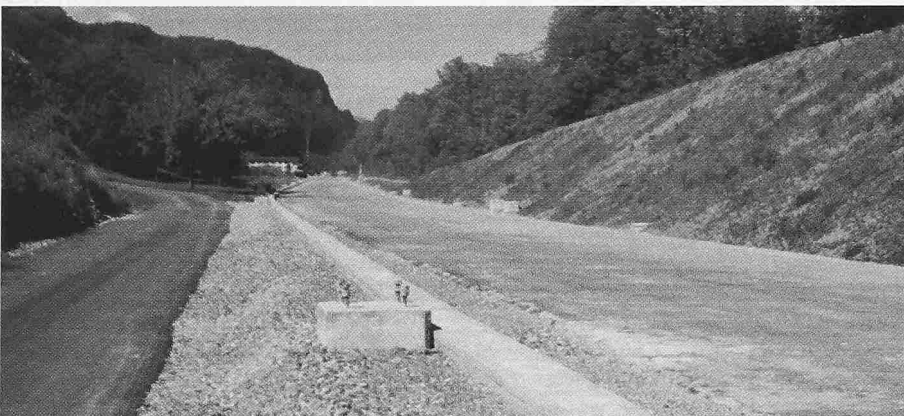
Bild 7. Trasse der neuen Linie, OK Fundamentalschicht
