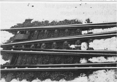
Bild 12. Weichenheizung in Betrieb
