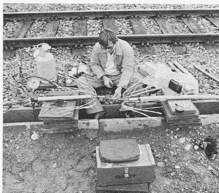
Bild 10. Kabelmonteur bei der Spleissarbeit
